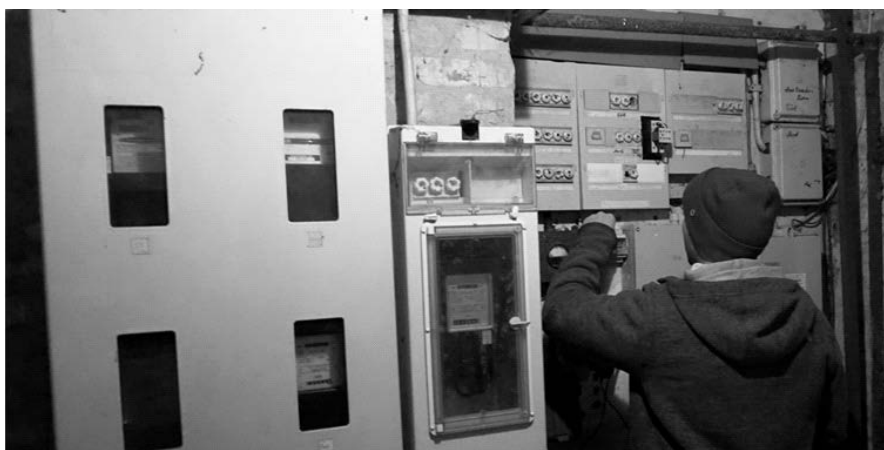
Am Einspeisepunkt wird die Steuerung eingebaut
